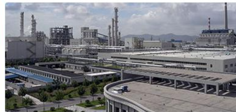
上海泖港工业园
